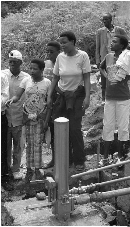
Pumpe noch ohne Gehäuse
